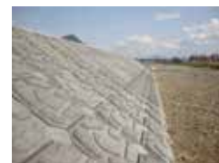
連結部着色コンクリート処理
