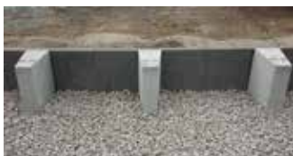
ドレーン材敷設状況
